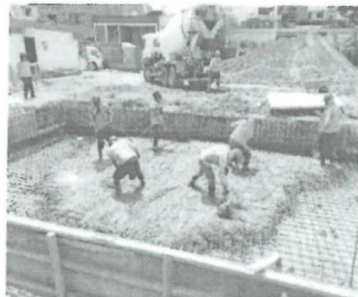
**FOTO 18.- CONSTRUCCION DE 127.87 M3 DE CONCRETO EN PISCINA**
