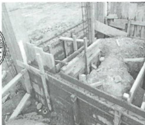
**FOTO 17.- CONSTRUCCIÓN DE 24.20 M3 EN ZAPATAS**
