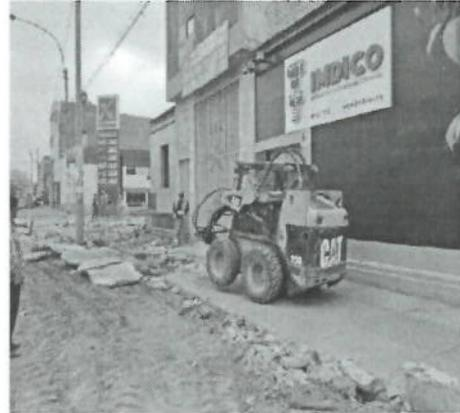
**FOTO 26.- DEMOLICIÓN DE VEREDAS DE CONCRETO**
