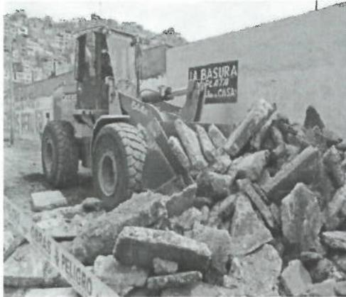
**FOTO 25.- DEMOLICIÓN DE CARPETA ASFÁLTICA EXISTENTE**
