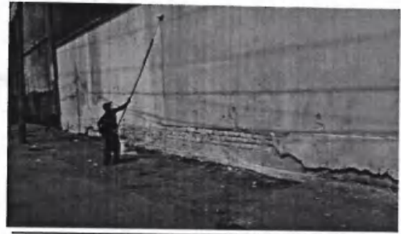
DESPUES - LAVADO Y PINTADO DE PARED
