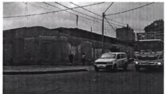
DESPUES RECUPERACIÓN DEL CRUCE DE PROLONGACIÓN HUAMANGA CON JR. HIPOLITO UNANUE.
