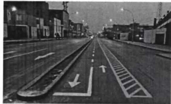
SEÑALIZACIÓN HORIZONTAL DE CICLOVÍAS
