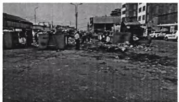
INSTALACIÓN DE CONTENEDORES Y RECOJO DE RESIDUOS SÓLIDOS MERCADO MODELO DE FRUTAS
