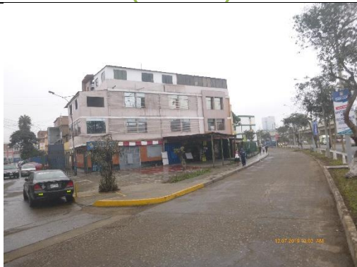
Fotografía 59 Colindante Casas multifamiliares y comercios (noroeste)
