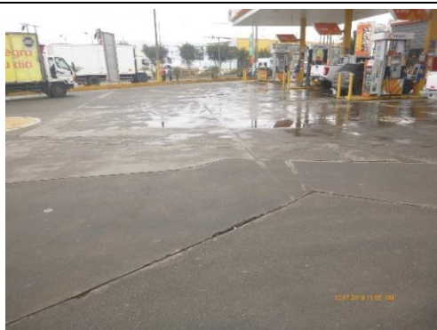
Fotografía 21 Losa zona islas
