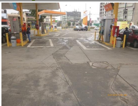
Fotografía 24 Losa zona islas
