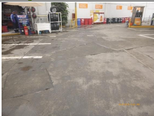
Fotografía 23 Losa zona llantería
