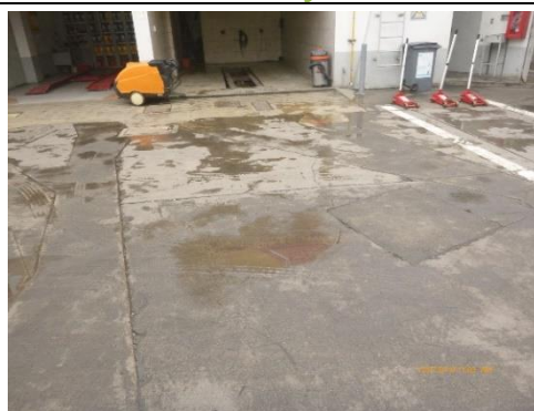
Fotografía 22 Losa zona centro de lubricación y lavado
