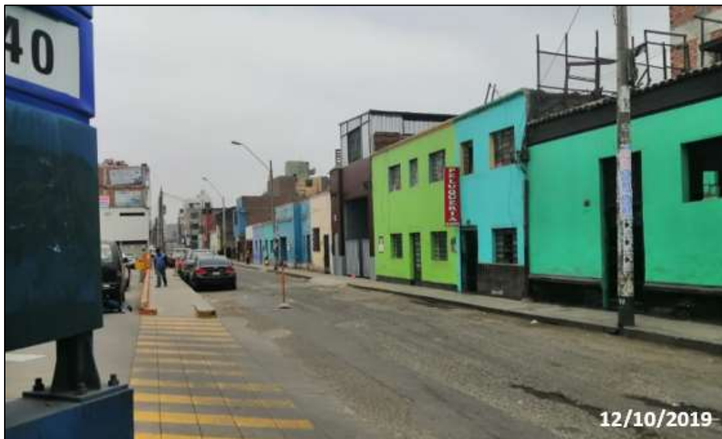
Imagen N° 8. Vista de viviendas alrededor del Establecimiento
