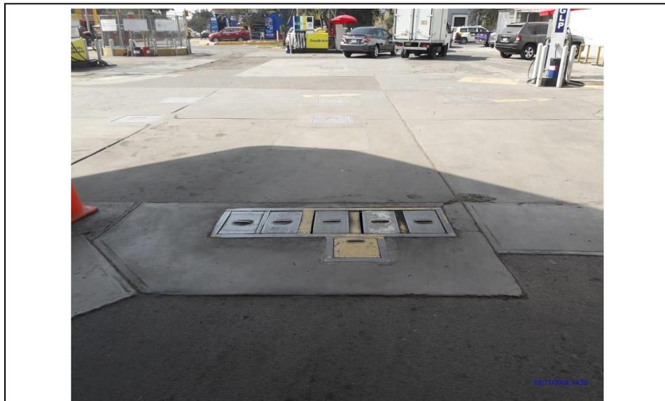
**Fotografía N° 3.** Vista de la zona de descarga de C.L., esta zona se encuentra encofrada por concreto
