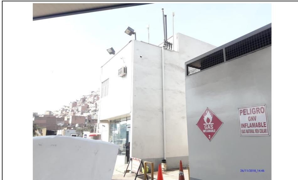
**Fotografía N° 4.** Vista del venteo de C.L., son un dispositivo diseñado para aliviar la presión y/o vacío para los tanques de almacenamiento de baja presión o atmosférica
