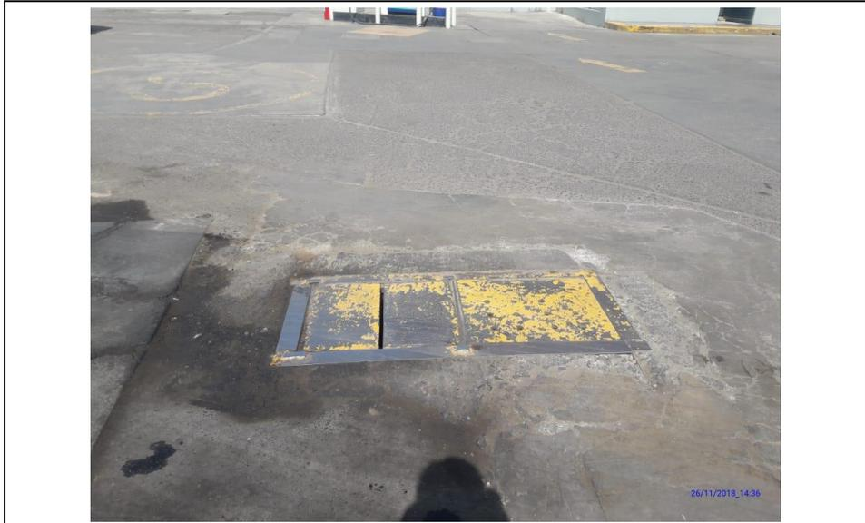
**Fotografía N° 6.** Vista de la zona de descarga de GLP, se encuentra próxima al tanque y está encofrada por concreto
