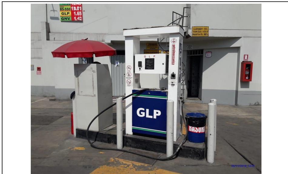
**Fotografía N° 5.** Vista de isla N° 3, la misma cuenta con un dispensador para GLP de 2 mangueras (1 por lado), y con una base de concreto de 20cm.
