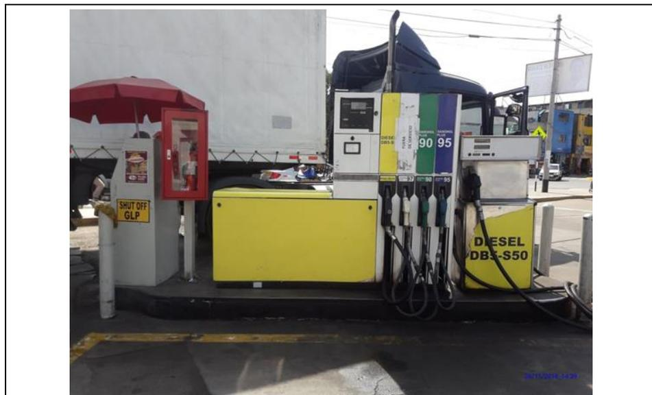
**Fotografía N° 1.** Vista de isla N° 1, la misma cuenta con un dispensador para C.L. de 8 mangueras (4 por lado) y con una base de concreto de 15cm.
