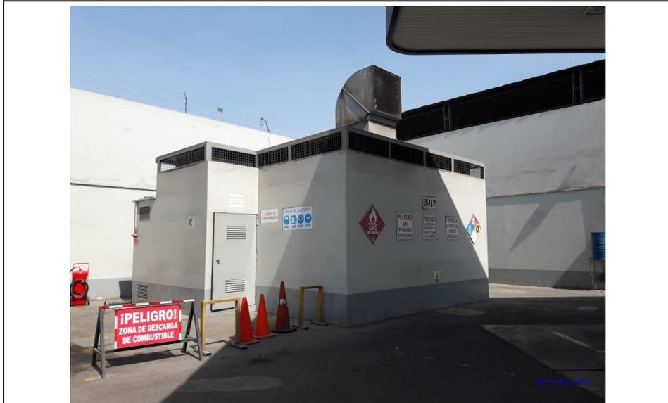
**Fotografía N° 8.** Recinto de Compresión y Almacenamiento, donde se ubica el compresor de GN y los cilindros de almacenamiento
