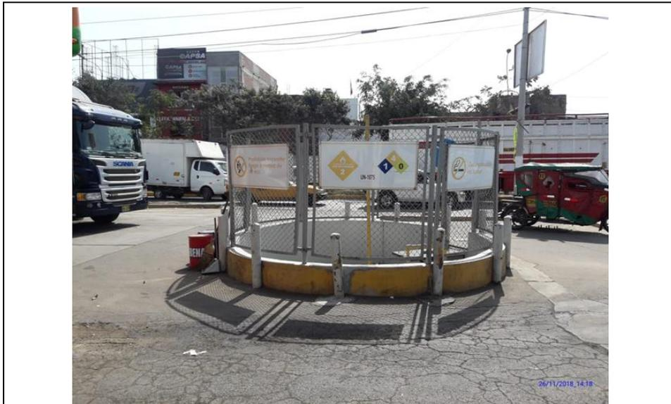
**Fotografía N° 7.** Vista del tanque de GLP, con capacidad de 2000 galones se encuentra soterrado de forma vertical en el patio de maniobras
